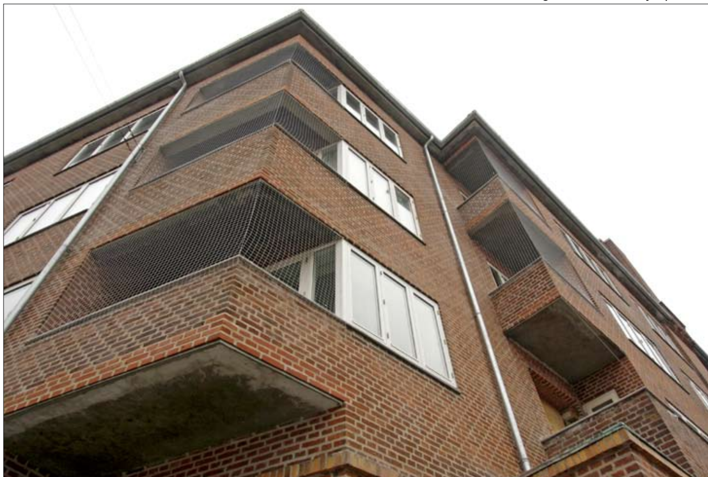
Foranstaltning mod duer ved hjælp af net
