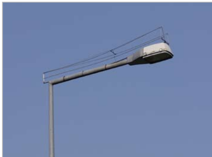
Mange steder kan det af hygiejniske grunde være nødvendigt at opsætte spærringforanstaltninger, der forhindrer måger eller duer at sætte sig
