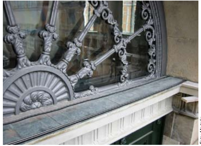
Et alternativ til fuglepigge er det såkaldte DuElsystem, der i princippet fungerer som et elektrisk markhegn
