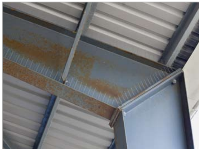
Fuglepigge kan være effektive ved rigtig montering
