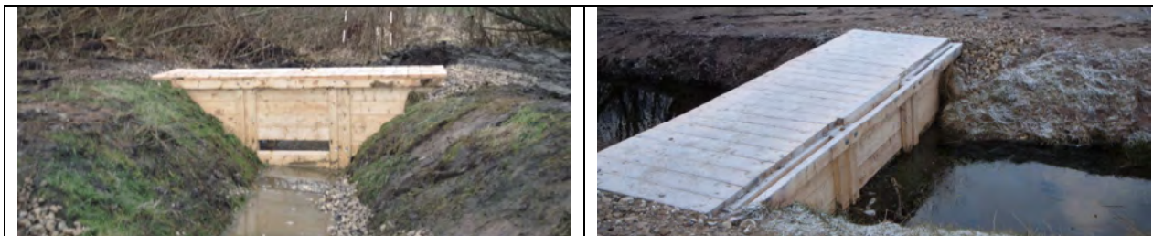
Figur 3: Angiver princip for et reguleringsbygværk (indløbsbygværk) til Svanemølle-søerne. Fotos viser reguleringsbygværk etableret i Guldbækken ved indløb til Vester Mølle sø i Svenstrup som blev etableret i forbindelse med nyt omløbsstryg i 2008. Bemærk, dykket løb til venstre (vandspejlet endnu ikke har indstillet sig).
