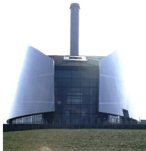
Kjeldgaard og Pedersen, Viborg kraftvarmeværk, Viborg Facadekeramik kan skabe hele flader, der i deres enkelhed kan skabe interessante kontraster til Katedralens "tunge" beton. Også her er der mulighed for at arbejde med fugernes betydning.
