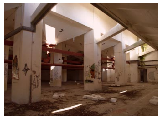
De pyramideformede silobunde med lysindfaldet fra vinduerne i karnapperne.
