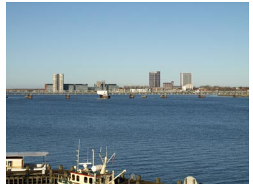
Elevatortårnet med kuppeltaget renoveres som en væsentlig del af Katedralens karakteristiske silhouet set fra Limfjordsbroen.
