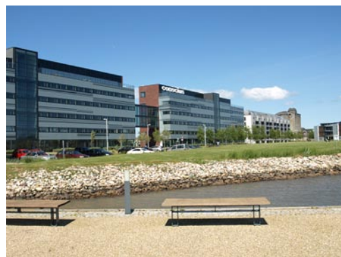
DAC Towers komposition af to rektangulære bygningskroppe svarer til de øvrige nye bygninger langs Lindholm Brygge. Hvor disse har en horisontal orientering, vil DAC Tower have en vertikal orientering.
