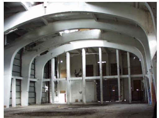
Mølleriets beton-buespær med pult-opbygning mod vest. Søjlerne bagest i mølleriet markerer overgangen til en nyere udvidelse.
