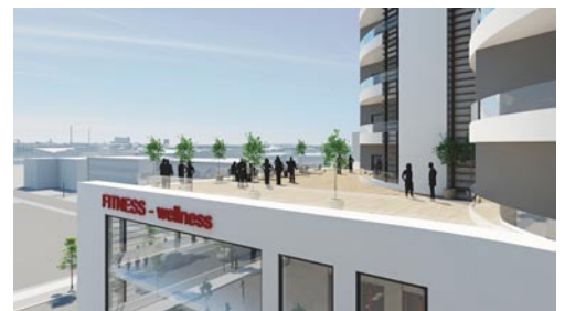
Værn udføres i glas omkring den fælles tagterrasse på basen og på terrasserne til boligerne i Triplet Tower.
