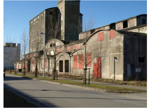
Maskinrummene med de buede tagkonstruktioner mod Lindholm Brygge. Den nærmeste sidebygning er en nyere tilbygning, der ligesom Mølleriets nye gavl er udført uden den detaljering af facaderne, som ses på det øvrige af Katedralen.
