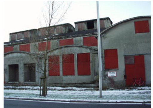
Mølleriet med tre tagryttere og lukkede vinduer "gemt" bag mindre maskinrum med buetage.
