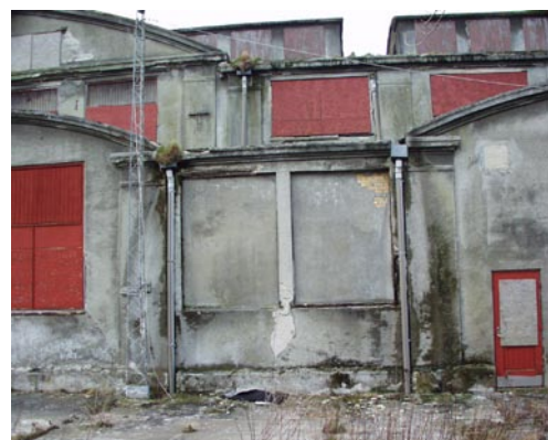
Katedralen er i kraftig forfald efter mange års slid og manglende vedligehold.
