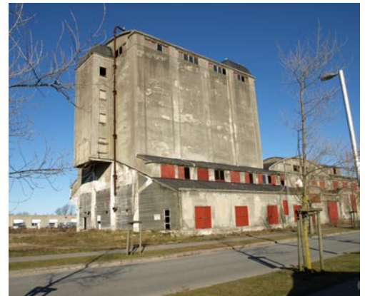
Silobygningen med pilastrene, det udkragende trappetårn mod syd og sidebygningen mod Lindholm Brygge. Elevatortårnets kuppeltag anes bag den nordlige del af silobygningen
