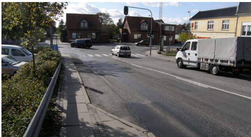
Billedet er set fra Viaduktvej mod krydset
