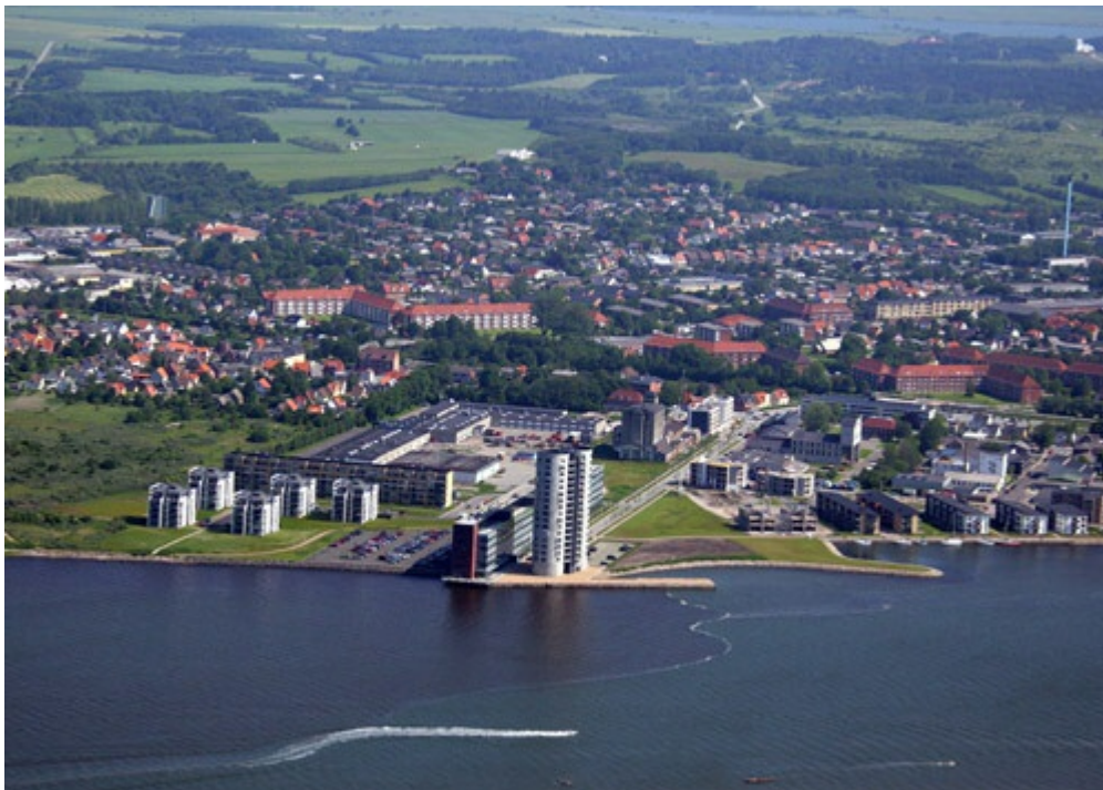
Omdannelsen af Lindholm Brygge er næsten færdig og området fremtræder som et nyt attraktivt område med store rekreative kvaliteter.
